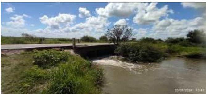
Foto 12.3-1 Erosión próxima a alcantarilla. (Vta. 1)
