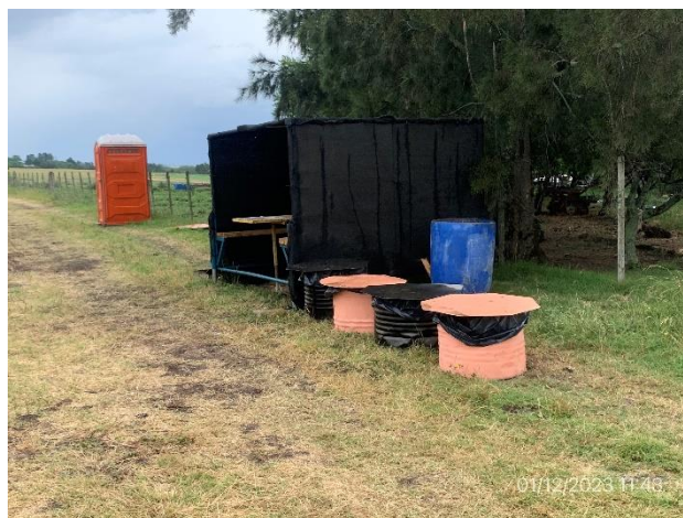
Foto 12.1-10, P03. Campamento provisorio, servicios de confort para operarios y estación de acopio de residuos.
