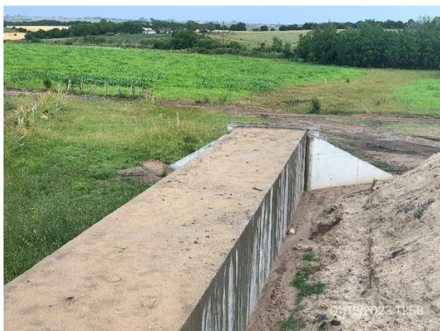
Foto 12.1-3. Tramo en obra, alcantarilla tipo H terminada.
