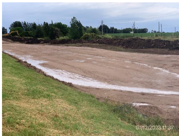
Foto 12.1-6. Tramo en obra, acopio de suelo vegetal en faja pública para reuso posterior.
