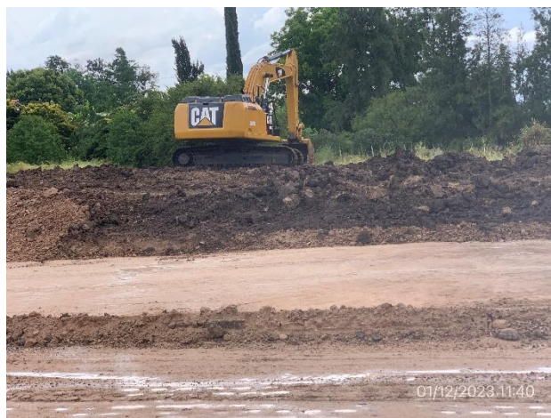
Foto 12.1-8, P04. Frente de obra, By Pass Ruta 1 progresiva 119K600.
