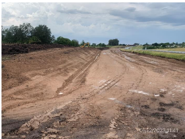
Foto 12.1-5. Tramo en obra, recargo de base granular en ejecución.
