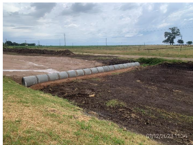
Foto 12.1-4. Tramo en obra, alcantarilla tipo Z en construcción.
