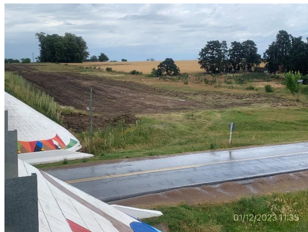
Foto 12.1-2. Emplazamiento de futuro puente en senda duplicada, By Pass Ruta 1 progresiva 123K100.
