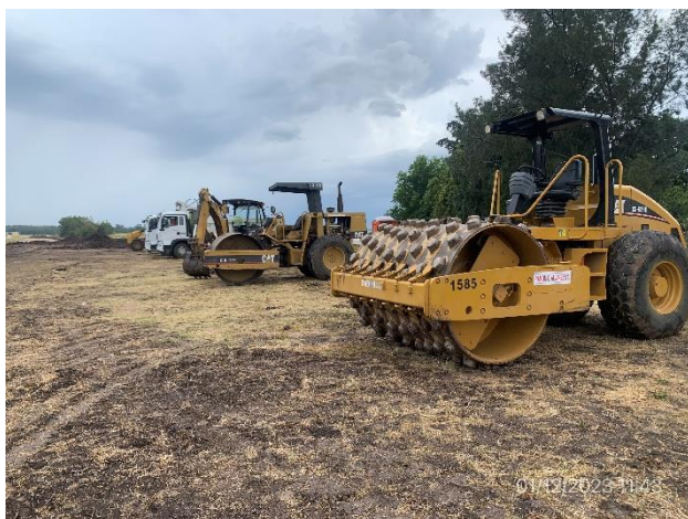
Foto 12.1-9, P03. Campamento provisorio, estacionamiento de maquinaria.
