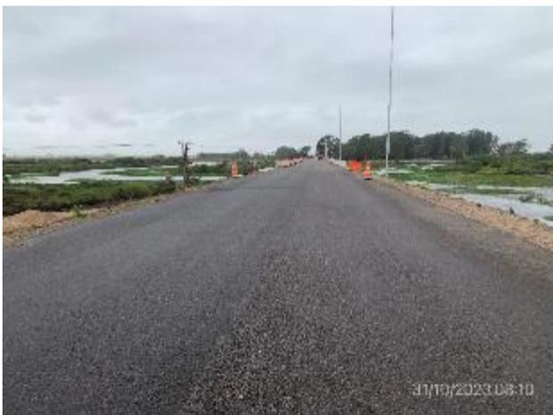
Foto 12.2-5. Carpeta asfáltica ejecutada en ensanche y readecuación de accesos a ambos puentes.
