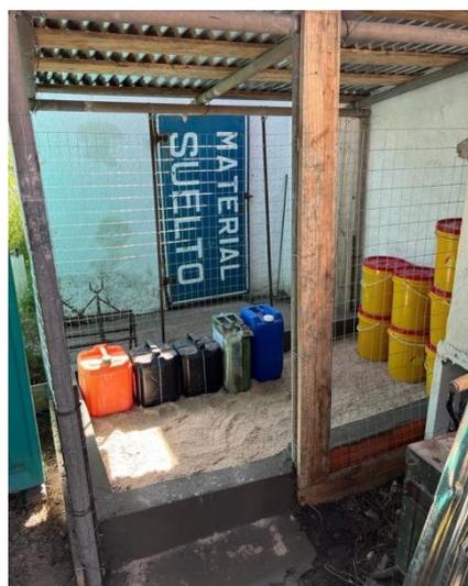
*Ilustración 21 – P03, Obrador. Sector envuelto e impermeabilizado para depósito de combustibles. Fotografía proporcionada por Techint SACI el 17/02/2023.*
