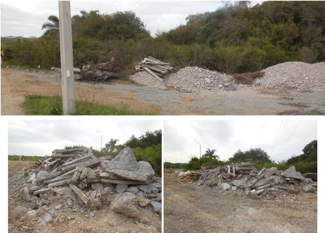
Figura 3-7 Acopio de ROCs en obrador principal
