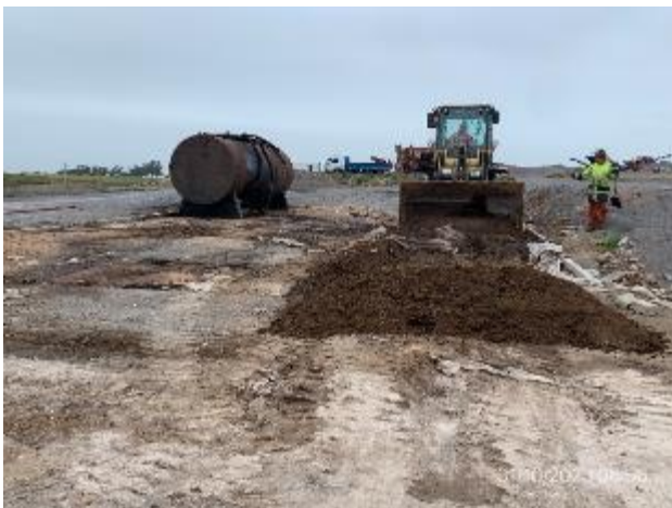
Foto 12.1-9, P06. Plataforma de apoyo de la planta asfáltica en proceso de remediación
