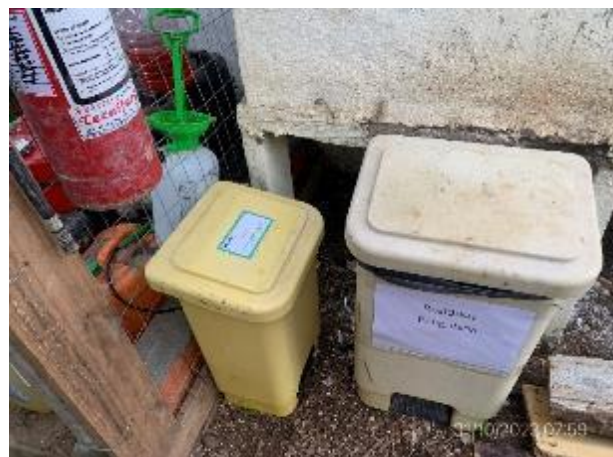
Foto 12.1-6, P05. Obrador. Estación de acopio de residuos peligrosos.
