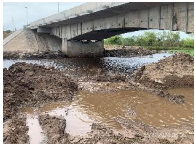
Foto 12.2-4, P01. Puente principal, curso de agua limpio sin restos de ROCs. Ataguía pendiente de ser removida.
