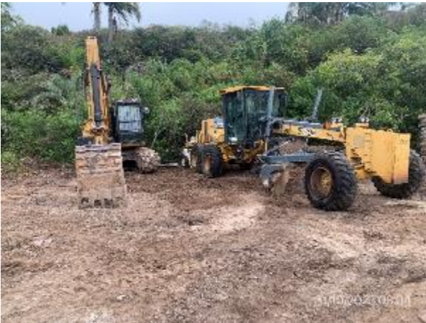
Foto 12.1-1, P05. Obrador, faja pública de Ruta 19, progresiva 8K200. Zona de estacionamiento.
