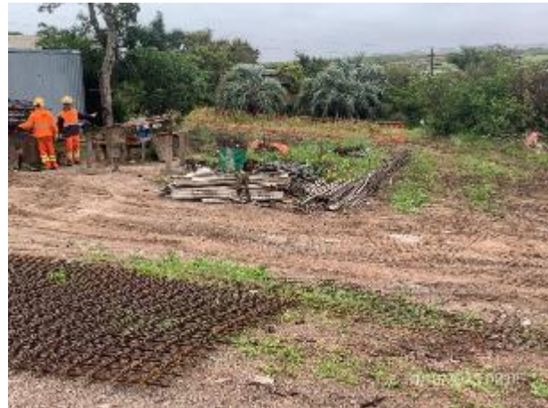
Foto 12.1-2. P05. Obrador. Zona de preparación de armaduras con buenas condiciones de orden.
