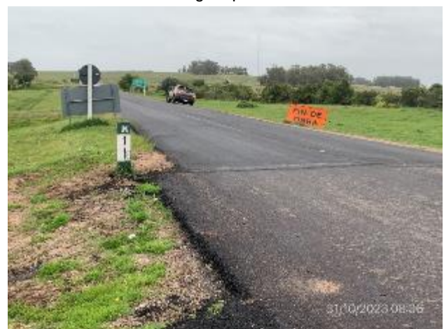
Foto 12.2-6, P04. Fin de tramo, Ruta 19 progresiva 11K000. Obras terminadas.
