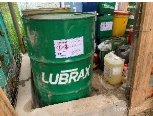
Foto 12.1-5, P05. Obrador, recinto envallado para acopio de lubricantes y productos peligrosos
