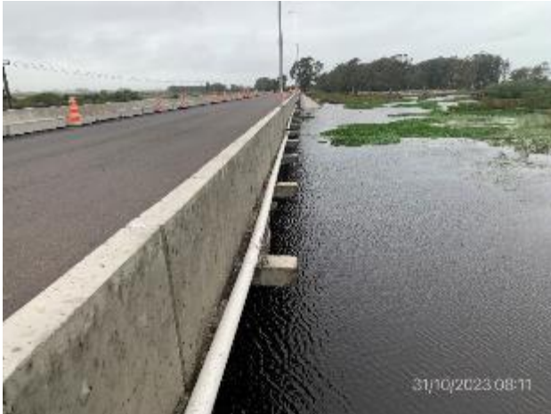
Foto 12.2-1, P02. Puente secundario en Ruta 19 progresiva 7K995. Tablero terminado. Cauce limpio.
