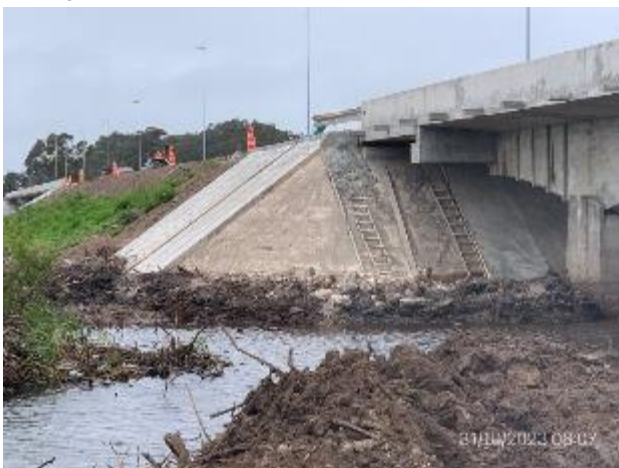
Foto 12.2-3, P01. Puente principal en Ruta 19 progresiva 7K720. Obras en ejecución en cuartos de cono.
