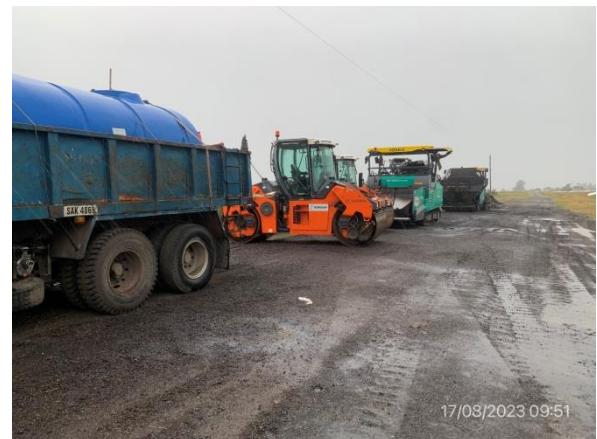
Foto 12.1-4 Estacionamiento de maquinaria y equipos en faja pública de Ruta 8 progresiva 217K500.
