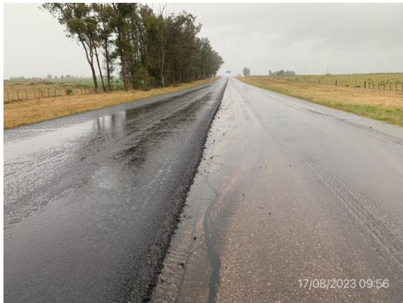
Foto 12.2-1 – Ruta 8, tramo de recapado ejecutado.
