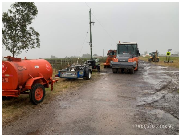
Foto 12.1-3 Campamento provisorio en faja pública de Ruta 8 progresiva 217K500
