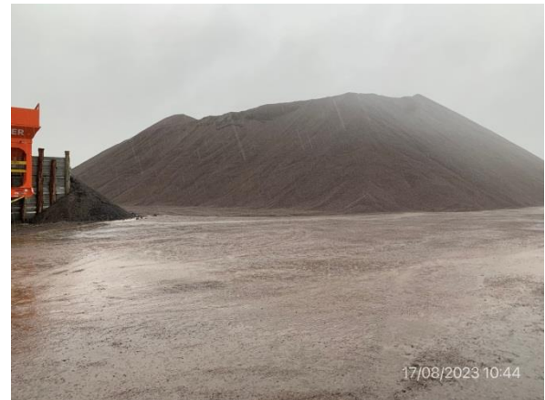
Foto 12.4-2 Acopio de material triturado.
