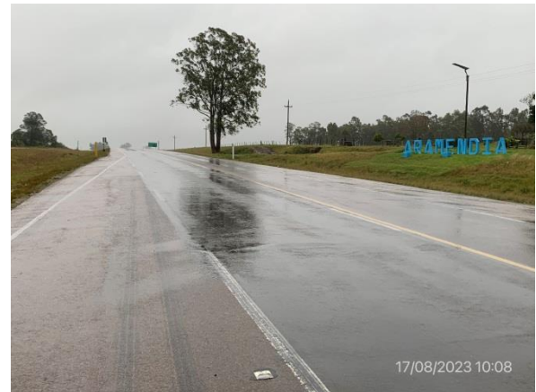
Foto 12.2-2 – P02, fin de tramo: Ruta 8 progresiva 235K000, acceso a Pueblo Aramendía.
