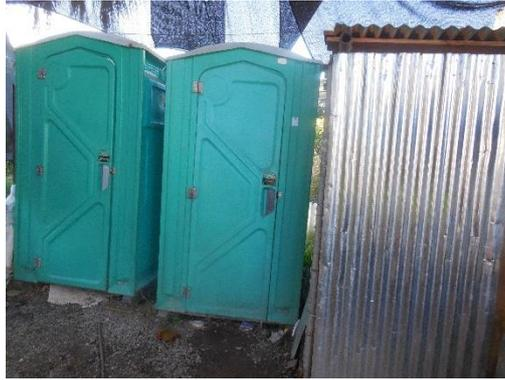
Figura 6-2 Baños conectados a pozo impermeable
