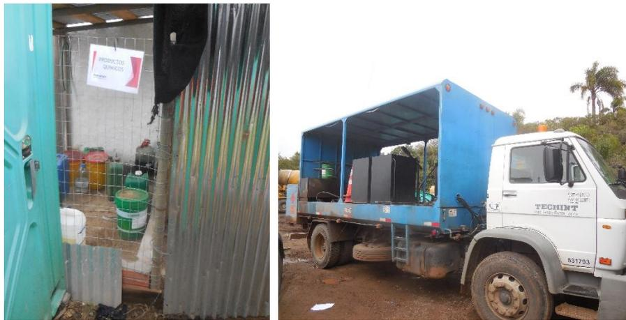
Figura 3-2 Recinto para el almacenamiento de envases con combustible y camión para mantenimientos
