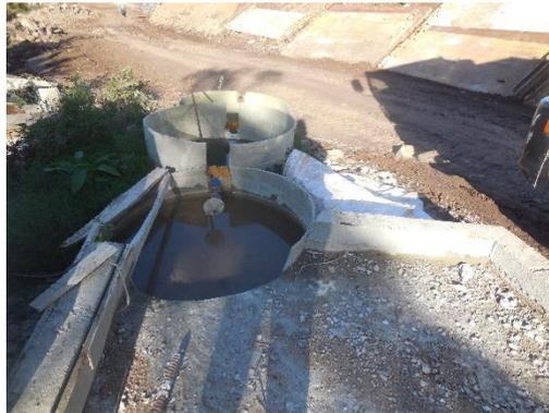
Figura 6-3 Pileta para lavado de herramientas con hormigón
