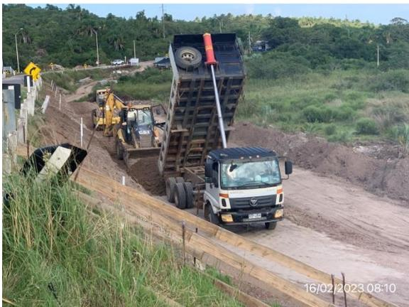
Ilustración 14 – P01, Puente principal sobre A° San Miguel. Trabajos de ensanche de terraplén en ejecución.
