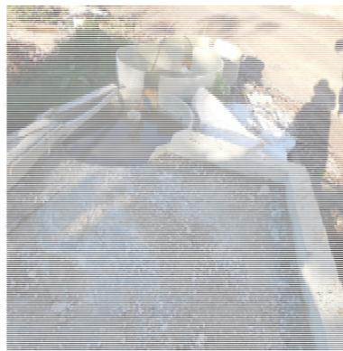
Figura 6-4 Pileta para lavado de herramientas con hormigón
