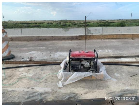
*Ilustración 17 – P01, Puente principal sobre A° San Miguel. Grupo electrógeno correctamente envuelto.*
