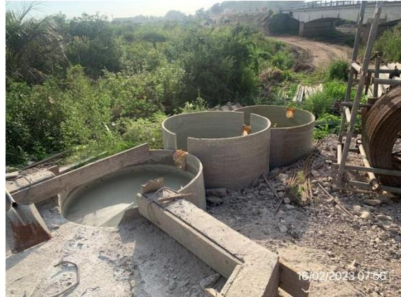
Ilustración 11 – P03, Obrador. Sistema de decantación de efluentes de lavado de camiones mixer.
