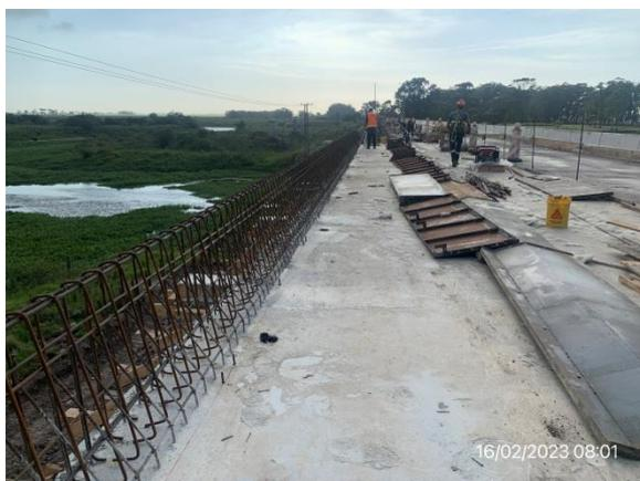
*Ilustración 16 – P01, Puente principal sobre A° San Miguel. Trabajos de ensanche de tablero.*
