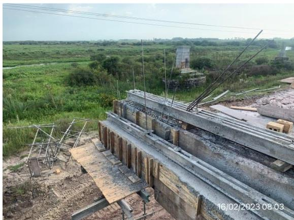
*Ilustración 18 – P01, Puente principal sobre A° San Miguel. Reconformación de vigas dintel.*
