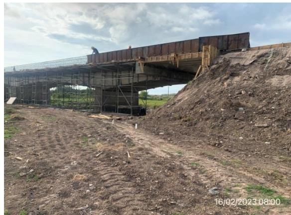
Ilustración 15 – P01, Puente principal sobre A° San Miguel. Trabajos en ejecución en cabecera Oeste.
