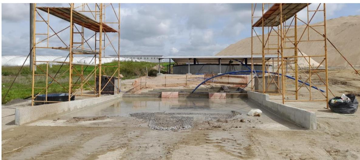
*Pileta de lavado de camiones de hormigón y herramientas*
