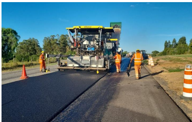
Recapado con mezcla asfáltica AM3
