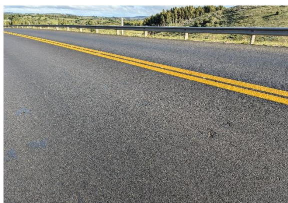
Recapado con mezcla asfáltica AM3
