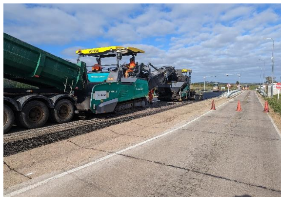
Recapado con mezcla asfáltica AM3
