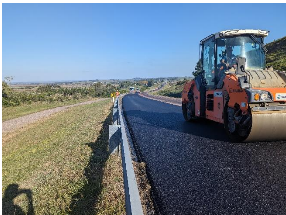
Recapado con mezcla asfáltica AM3
