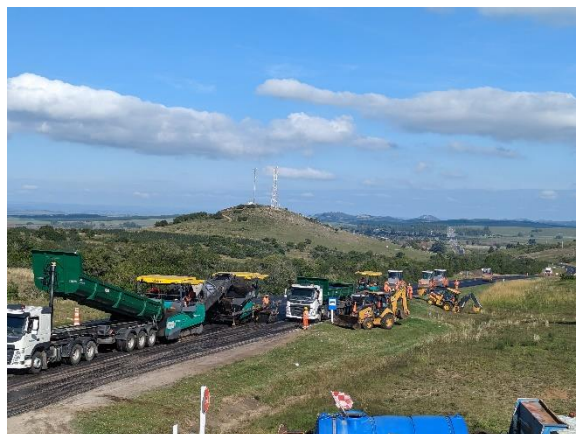
Recapado con mezcla asfáltica AM3
