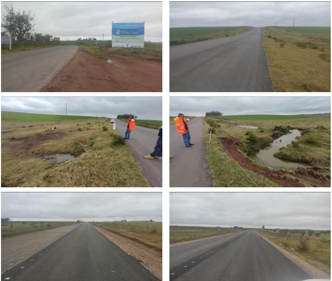
Foto 13.1-1 Vistas del tramo en obra.
