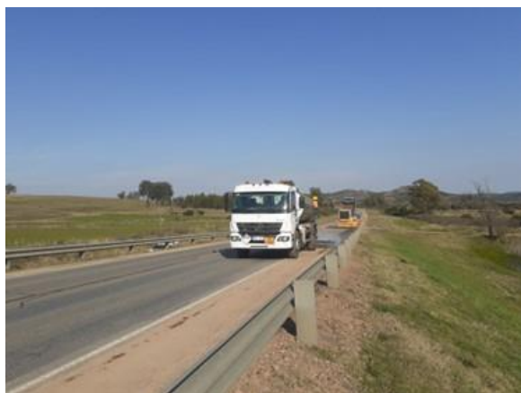
imprimación de banquetas cementadas en Obras N°1 N°2
