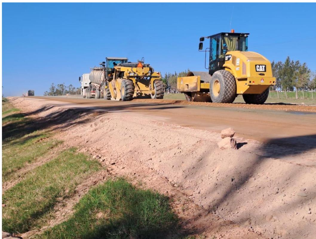
Imagen N° 5 y 6: Estabilizado con cemento.
