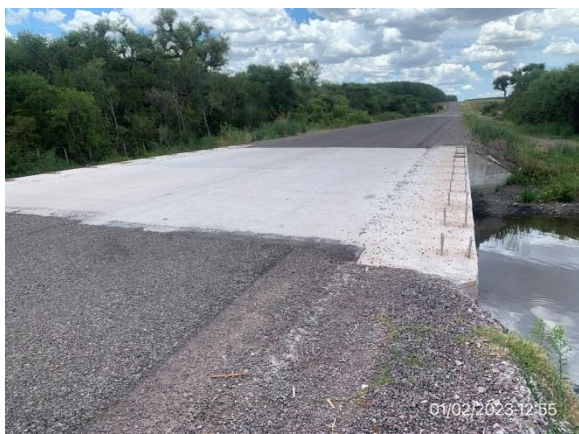
Ilustración 6 – P06, Alcantarilla construida. Cno. Los Cuadrados, progresiva 12K600.
