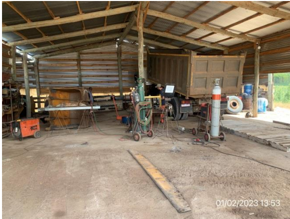
Ilustración 22 – P03, Obrador. Taller mecánico techado con pavimento impermeable.
