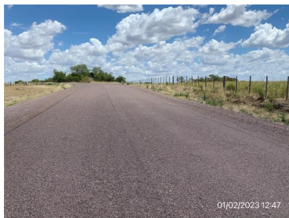
Ilustración 15 – Obra de Cno. Los Cuadrados terminada, carpeta de rodadura instalada.
