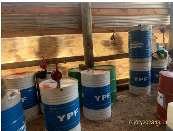
Ilustración 24 – P03, Obrador. Recinto envallado, techado y con pavimento impermeable para acopio de lubricantes y residuos peligrosos.
