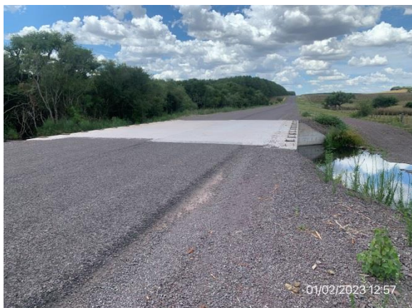
Ilustración 8 – P05, Alcantarilla construida. Cno. Los Cuadrados, progresiva 10K100.
