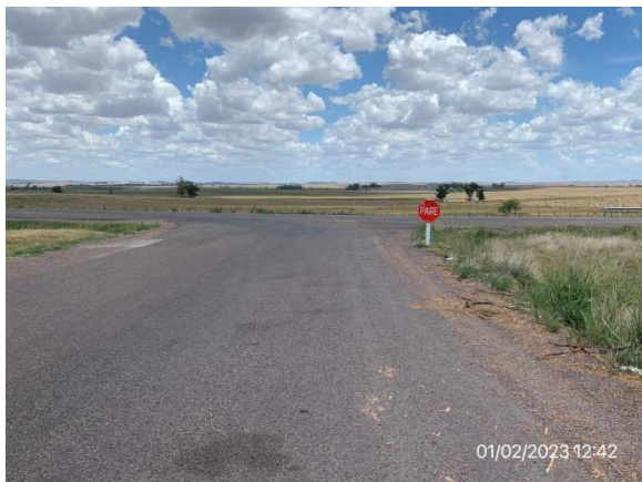
Ilustración 4 – P01, Inicio de tramo. Cno. Los Cuadrados progresiva 0K000. Empalme con Ruta 5.
