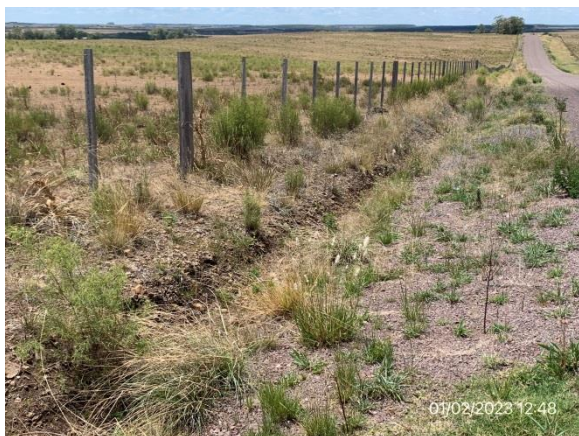
Ilustración 16 – Obra de Cno. Los Cuadrados terminada. Cunetas y drenajes construidos con cobertura vegetal en crecimiento.
