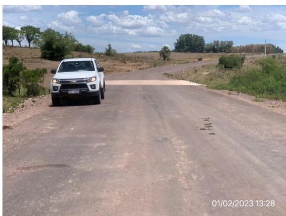
Ilustración 12 – P02, Fin de tramo. Alcantarilla construida. Cno. Los Cuadrados progresiva 34K000.
