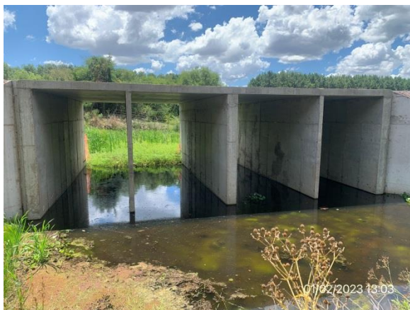
Ilustración 10 – P07, Alcantarilla construida. Cno. Los Cuadrados, progresiva 16K100.
