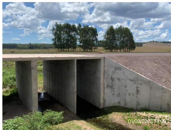
Ilustración 11 – P07, Alcantarilla construida. Recuperación ambiental correcta, curso de agua limpio y drenaje adecuado.
