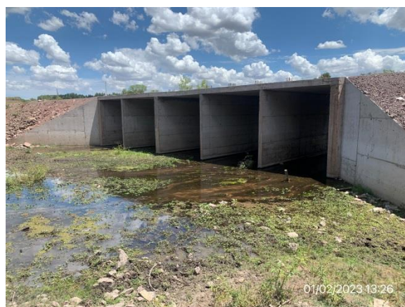
Ilustración 13 – P02, Fin de tramo. Alcantarilla construida. Recuperación ambiental correcta, curso de agua limpio y drenaje adecuado.
