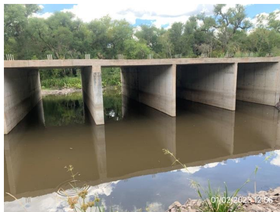
Ilustración 7 – P06, Alcantarilla construida. Recuperación ambiental correcta, curso de agua limpio y drenaje adecuado.
