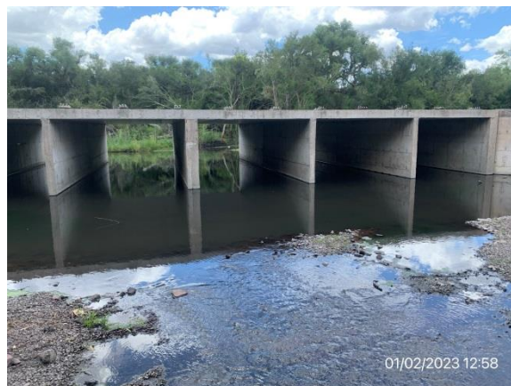
Ilustración 9 – P05, Alcantarilla construida. Recuperación ambiental correcta, curso de agua limpio y drenaje adecuado.
