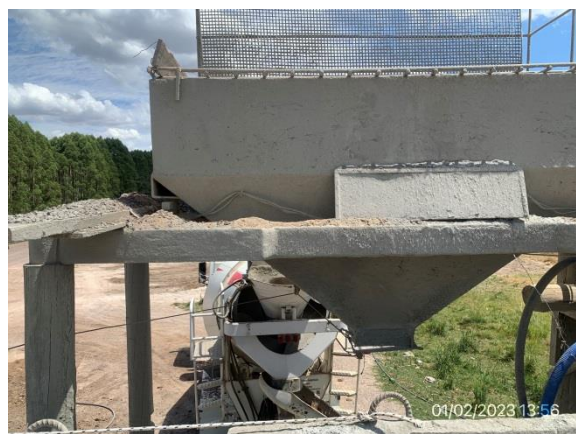
Ilustración 21 – P03, Obrador. Planta de hormigón.
