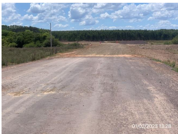
Ilustración 14 – P02, fin de tramo. Cno. Los Cuadrados progresiva 34K000, empalme con Cno. El Arbolito.
