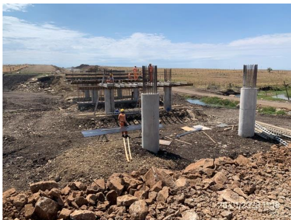
Ilustración 16 – P01, Puente sobre A° Tala en ejecución. Pilares en construcción.
