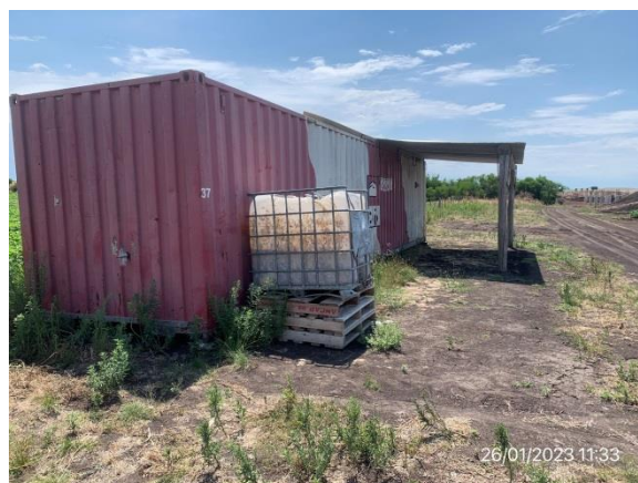
Ilustración 21 – P02, Puente sobre A° Rolón en ejecución. Campamento provisorio.
