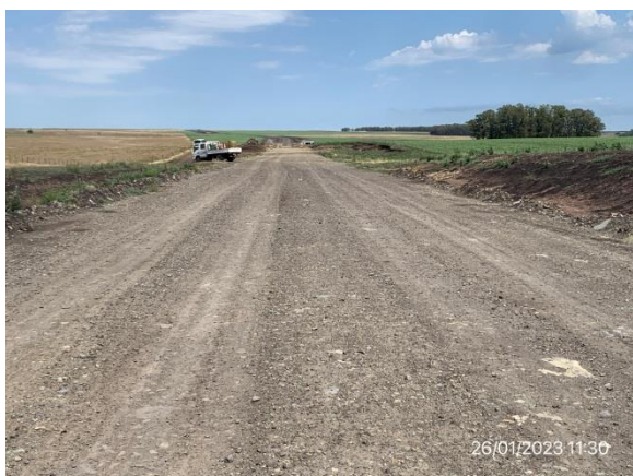
Ilustración 20 – Tramo de obra en construcción. Desmote y perfilado de subrasante parcialmente terminado.
