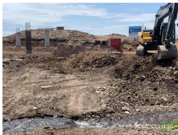
Ilustración 23 – P02, Puente sobre A° Rolón en ejecución. Tareas de excavación en proceso.
