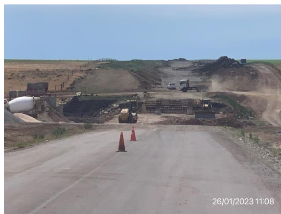
Ilustración 15 – P01, Puente sobre A° Tala en ejecución.
