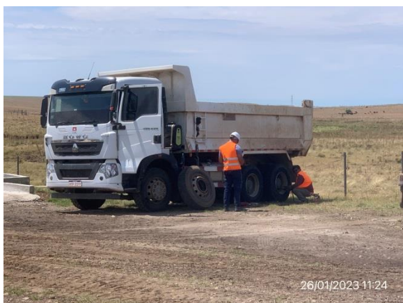
Ilustración 14 – P01, obrador principal. Tareas de mantenimiento menor de maquinaria en ejecución sobre suelo natural.
