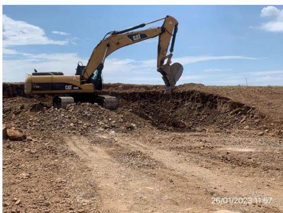
Ilustración 24 – P03, Cantera de basalto. Tareas de excavación en frente activo en explotación.
