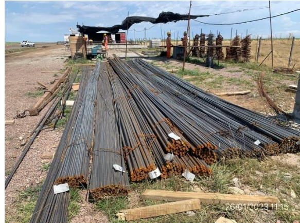
Ilustración 5 – P01, Obrador principal. Acopio de armaduras y taller de armaduras.
