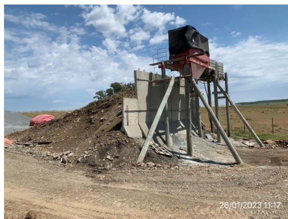
Ilustración 11 – P01, Obrador principal. Planta de hormigón.
