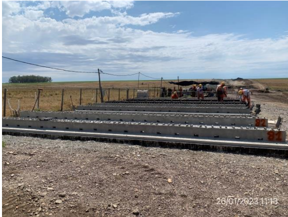
Ilustración 4 – P01, Obrador principal. Acopio de vigas prefabricadas.
