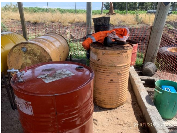
Ilustración 6 – P01, Obrador principal. Recinto envallado, techado y con pavimento impermeable para acopio de lubricantes y combustibles.
