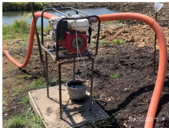
Ilustración 17 – P01, Puente sobre A° Tala en ejecución. Motobomba en funcionamiento en condiciones adecuadas.
