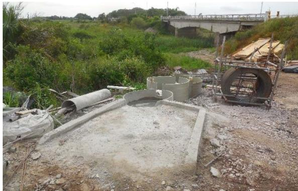
Figura 6-3 Pileta para lavado de herramientas con hormigón
