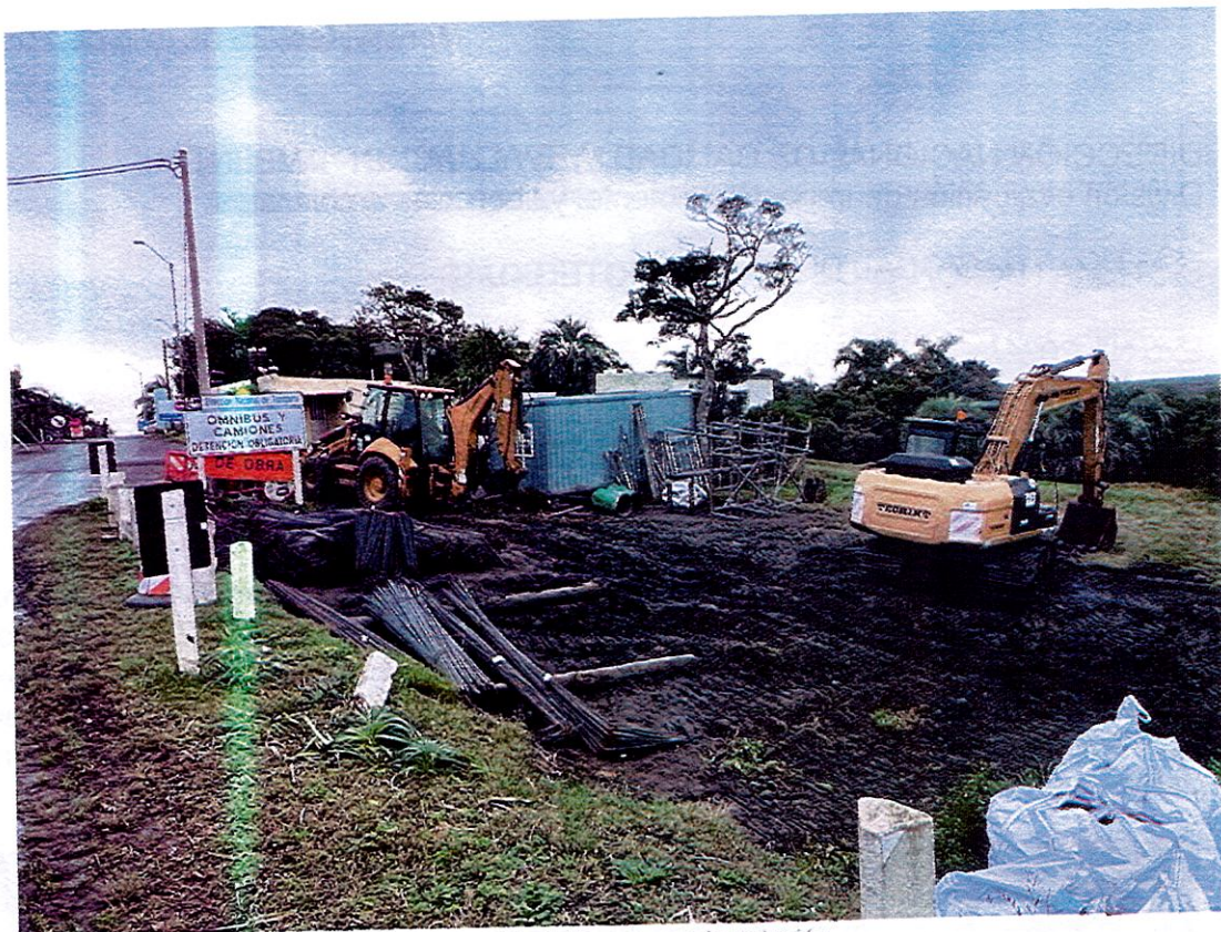
Ilustración 2 Obrador en instalación
