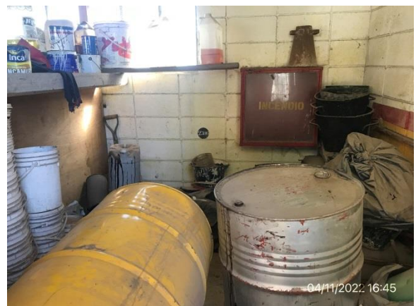
Ilustración 9 – P03, Obrador. Sector cerrado y techado para acopio de pinturas y solventes.
