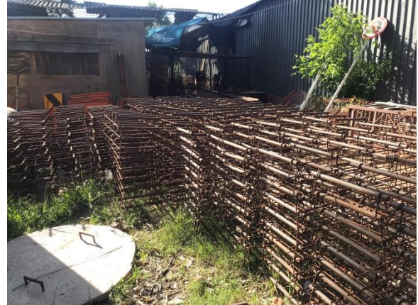
Ilustración 5 – P03, Obrador. Acopio de armaduras de pavimentos.
