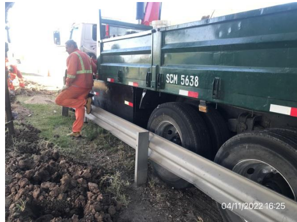
Ilustración 17 – P09, Frente de obra, Av. Luis Batlle Berres, puente sobre Ruta 5 progresiva 8K400. Cateo de infraestructura eléctrica existente.
