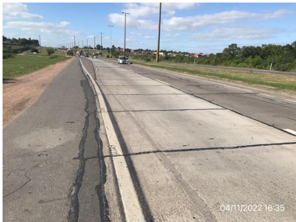
Ilustración 18 – Tramo de obra de mantenimiento terminado y abierto al tránsito. Bacheo en hormigón en carril parcial.
