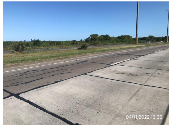
Ilustración 19 – Tramo de obra de mantenimiento terminado y abierto al tránsito. Nuevas juntas ejecutadas.
