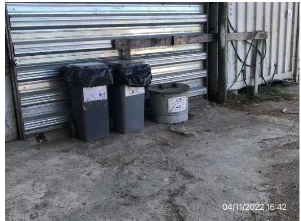
Ilustración 7 – P03, Obrador. Estación de acopio de residuos segregados por corriente de generación.
