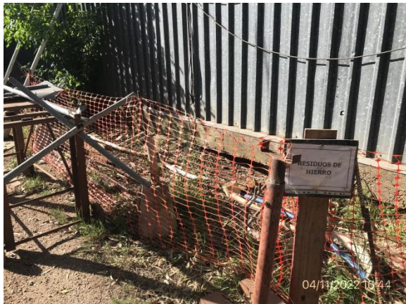
Ilustración 6 – P03, Obrador. Sector de acopio de residuos ferrosos.
