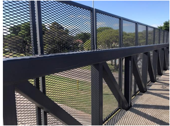
Ilustración 11 – P06, Obra terminada, puente peatonal progresiva 4K200. Estructura metálica terminada y montaje concluido.
