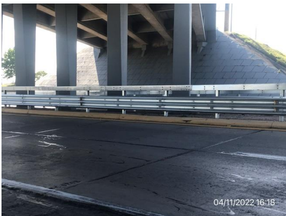
Ilustración 14 – P10, Obra terminada, Av. Millán, puente sobre Ruta 5 progresiva 10K800. Defensas metálicas colocadas.
