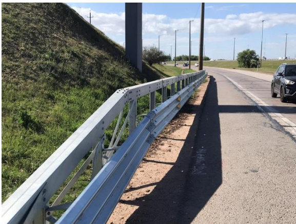
Ilustración 12 – P07, Obra terminada, intercambiador Rutas 1 y 5. Ruta 1 progresiva 6K500. Defensas metálicas colocadas.
