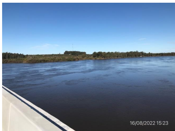
Ilustración 12 – P01, Puente terminado sobre el río Negro. Curso de agua sin evidencias de restos de obra, ROCs u otros.
