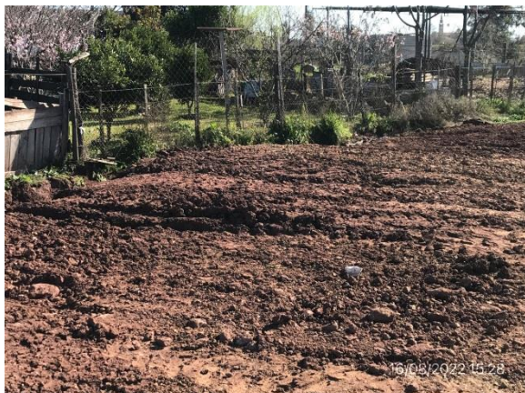
Ilustración 8 – P02, Obrador desmontado. Pozo impermeable desmantelado y rellenado.
