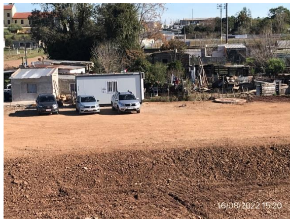
Ilustración 9 – P02, Obrador desmontado. Sector de estacionamiento de maquinaria y acopios varios, libre de ROCs y recuperado.
