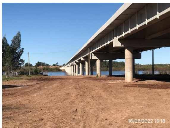
Ilustración 7 – P01, Puente terminado. Sector de acopio de camisas metálicas y armaduras recuperado.
