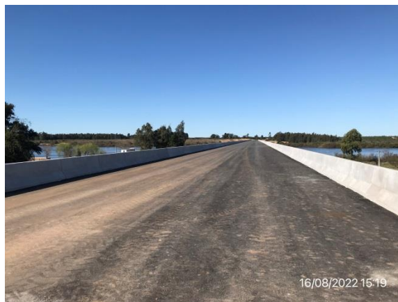
Ilustración 11 – P01, Puente terminado. Carpeta de rodadura lista para ser abierta al tránsito
