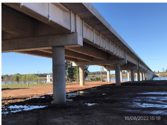
Ilustración 6 – P01, Puente terminado. Sector de acopio de prefabricados de hormigón recuperado.
