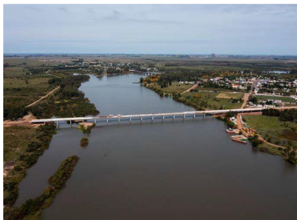
Ilustración 10 – P01, Puente terminado. Fotografía proporcionada por la contratista.
