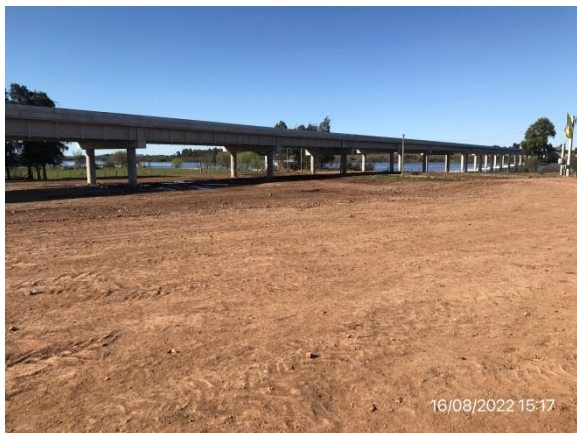
Ilustración 4 – P02, Obrador desmontado. Pañol, sector de herrería baños y comedores desmontados.
