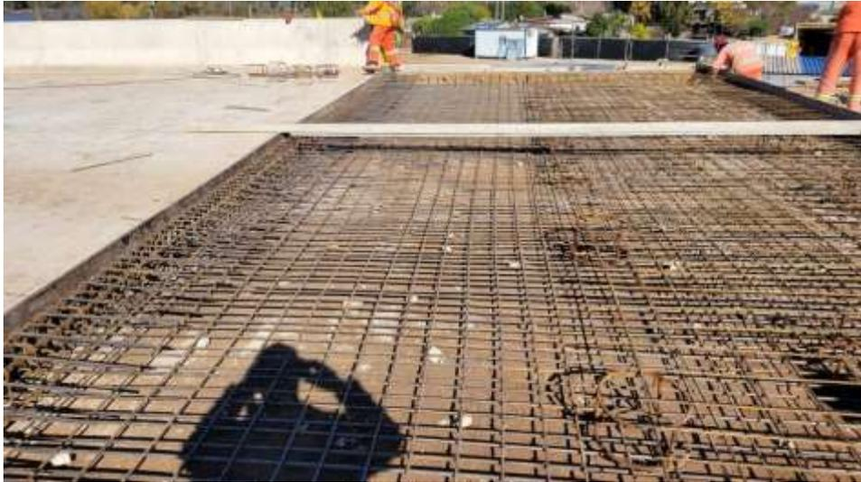
**Figura 1:** armadura de losa de acceso
