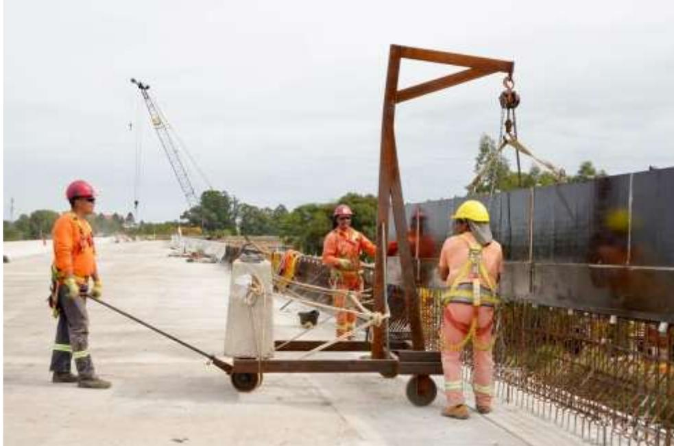
**Figura 2:** encofrado de New Jersey
