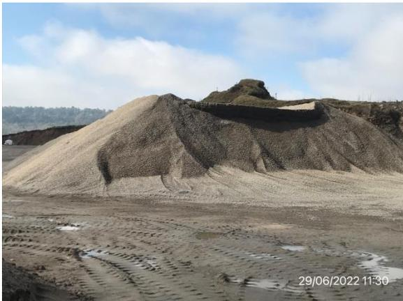
Ilustración 18 – P03, Obrador. Acopio de polvo de cantera para mezcla asfáltica
