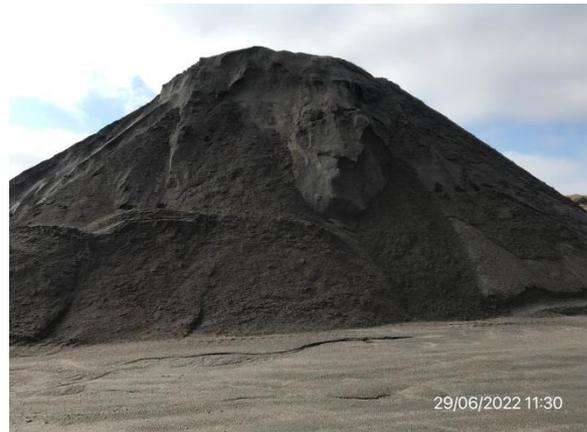
Ilustración 19 – P03, Obrador. Acopio de piedra triturada de cantera para mezcla asfáltica
