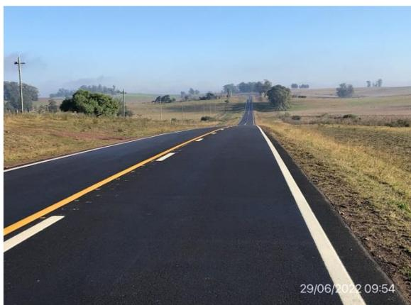
Ilustración 6 – Ruta 44. Trabajos de ensanche de plataforma y nueva carpeta asfáltica ejecutados.
