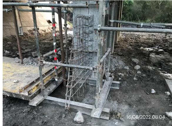
Ilustración 5 – P07, Puente sobre A° Pantanoso. Recreido de pilares en ejecución.
