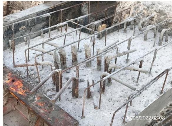
Ilustración 7 – P07, Puente sobre A° Pantanoso. Nuevos pilotes de fundación ejecutados.
