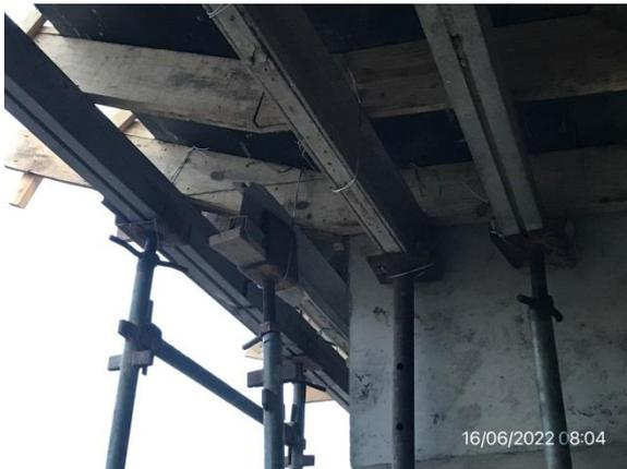
Ilustración 6 – P07, Puente sobre A° Pantanoso. Recreido de tablero en ejecución.
