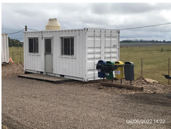
Ilustración 20 – P03, Obrador. Sector para segregación de residuos por corriente de generación.
