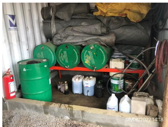
Ilustración 15 – P03, Obrador. Acopio de lubricantes en recinto cerrado y con bandeja impermeable.
