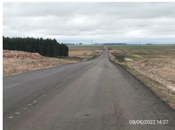
Ilustración 7 – Ruta 20, Tramo construido. Carpeta asfáltica ejecutada.
