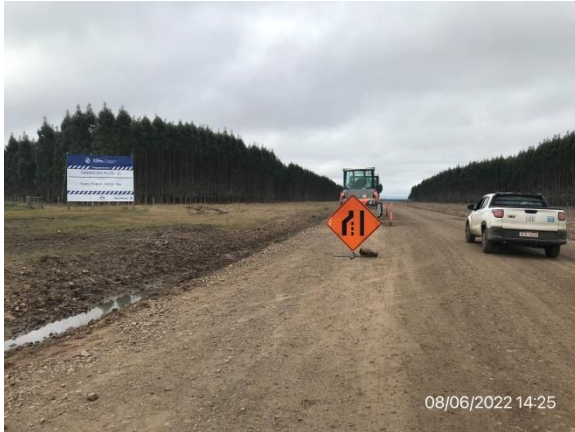
Ilustración 4 – P01, Inicio de tramo en Ruta 20. Nuevo trazado, progresiva 0K000, empalme con Ruta 4.
