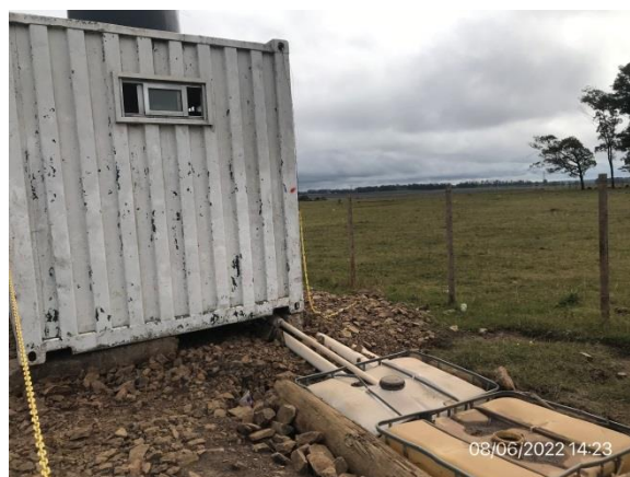
Ilustración 21 – P03, Obrador. Depósito impermeable de aguas servidas.
