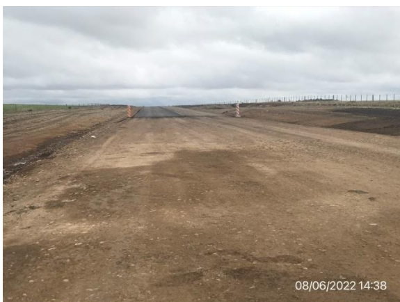
Ilustración 8 – P02, Fin de tramo. Cabecera de puente en A° Tala.
