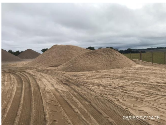
Ilustración 14 – P03, Obrador. Explanada de acopio de áridos.
