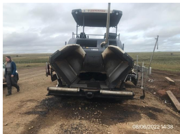
Ilustración 9 – P02, Fin de tramo. Maquinaria terminadora de Asfalto bajo tareas de mantenimiento mecánico liviano fuera de las condiciones previstas.
