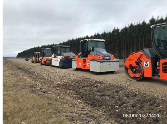
Ilustración 5 – P01, Inicio de tramo en Ruta 20. Nuevo trazado, progresiva 0K000, empalme con Ruta 4. Frente de obras.
