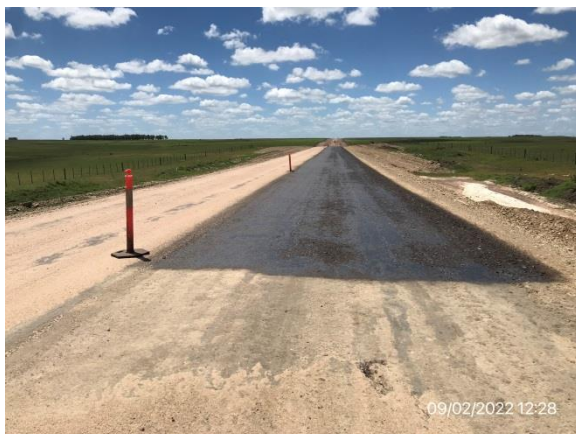
Ilustración 6 – Nuevo trazado de Ruta 20, base granular imprimada.
