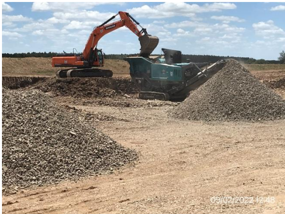
Ilustración 12 – P03, Cantera de basalto. Trabajos de trituración en ejecución. .
