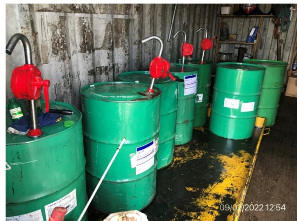
Ilustración 15 – P03, Obrador. Acopio de lubricantes en recinto cerrado y con bandeja impermeable.
