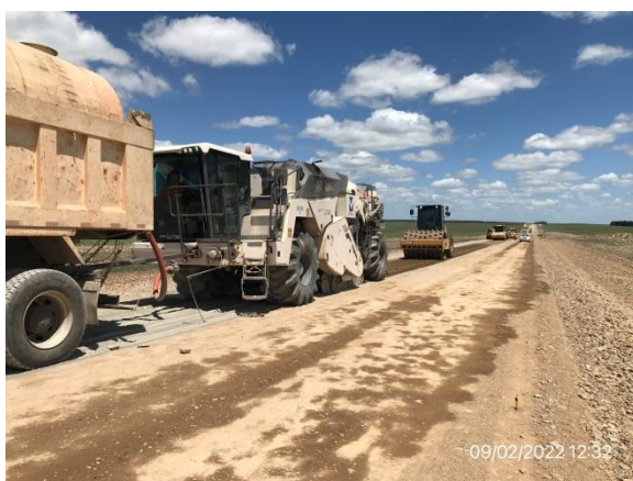
Ilustración 8 – P04, Frente de obra. Trabajos de cementado de base granular en ejecución.
