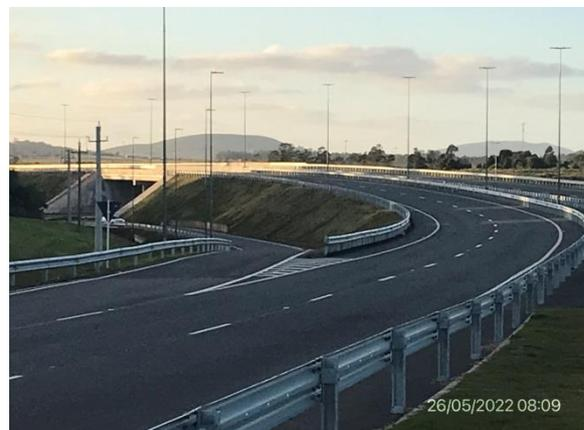
Ilustración 9 – P01, Señalización vertical y horizontal en intercambiador de Acceso a Balneario Solís culminadas
