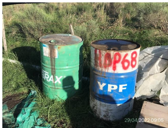
Ilustración 11 – P03, Obrador principal. Tarrinas de combustible y perclorotileno dispuestas sobre suelo desnudo, sin estructura de contención antiderrames.
