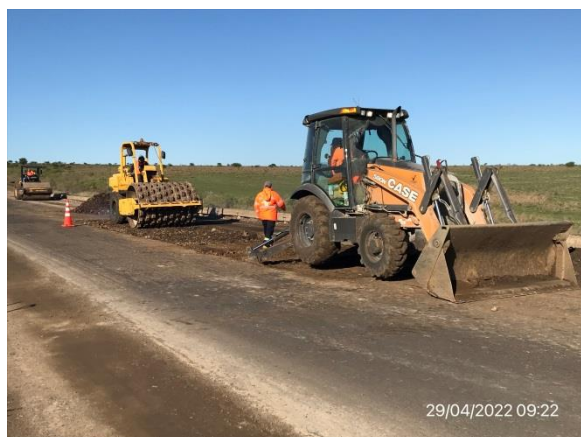
Ilustración 6 – P04, Frente de obras. Tareas de reconformación de base granular en cabecera sur del puente de Ruta 3 sobre río Arapey.
