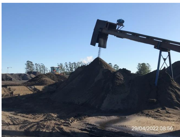
Ilustración 18 – P03, cantera de basalto. Acopios de áridos.
