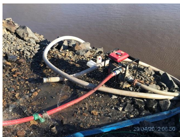
Ilustración 15 – P03, Cantera de basalto. Motobomba y reservorio de combustible sin estructuras de contención antiderrames.
