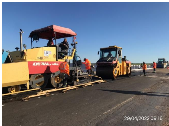
Ilustración 4 – P04, Frente de obras. Tareas de recapado en cabecera sur del puente de Ruta 3 sobre río Arapey.
