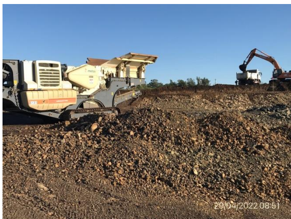
Ilustración 16 – P03, cantera de basalto. Tren de trituración en funcionamiento.
