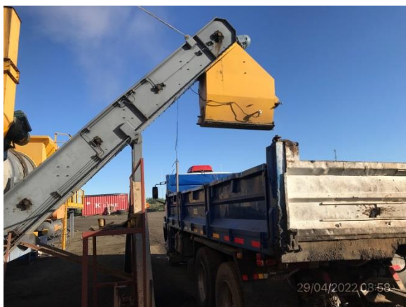
Ilustración 20 – P03, planta asfáltica, cinta de descarga de mezcla asfáltica con filtro de mangas.
