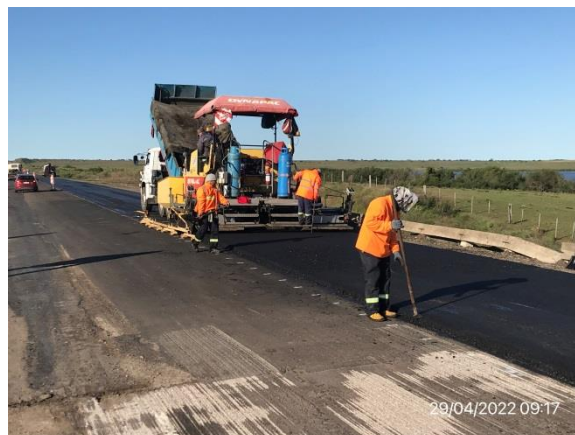
Ilustración 5 – P04, Frente de obras. Tareas de recapado en cabecera sur del puente de Ruta 3 sobre río Arapey.
