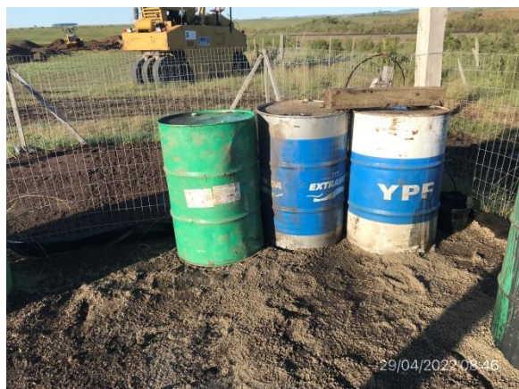
Ilustración 8 – P03, Obrador principal. Acopio de lubricantes usados en zona envallada con pavimento impermeable.
