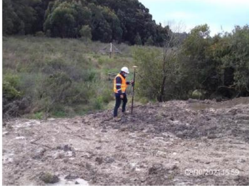
Ilustración 24 – P01. Zona de amortiguación de cañada utilizada para acopio de material de excavación en zona, Material retirado, sin protección vegetal
