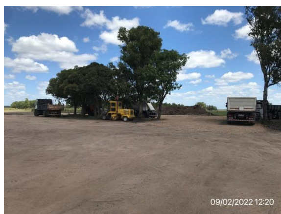
Ilustración 9 – P05, Campamento provisorio. Maquinaria vial y camiones estacionados.
