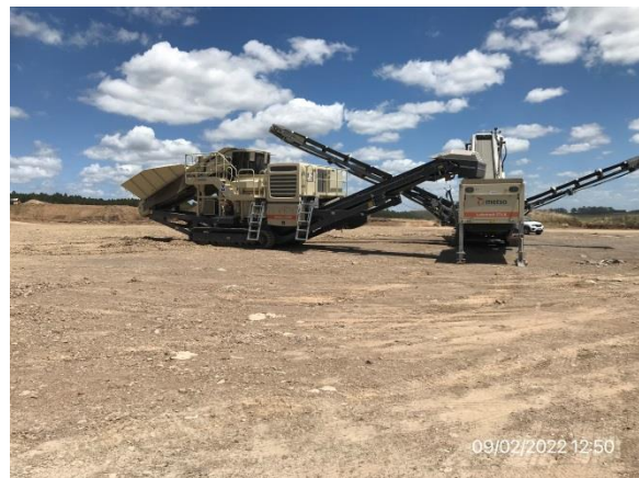
Ilustración 13 – P03, Cantera de basalto. Trabajos de trituración en ejecución. No hay infraestructura para gestión de residuos ni confort de operarios.
