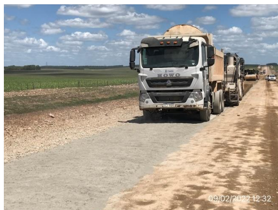
Ilustración 7 – P04, Frente de obra. Trabajos de cementado de base granular en ejecución.
