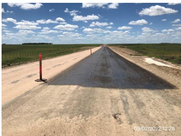
Ilustración 6 – Nuevo trazado de Ruta 20, base granular imprimada.
