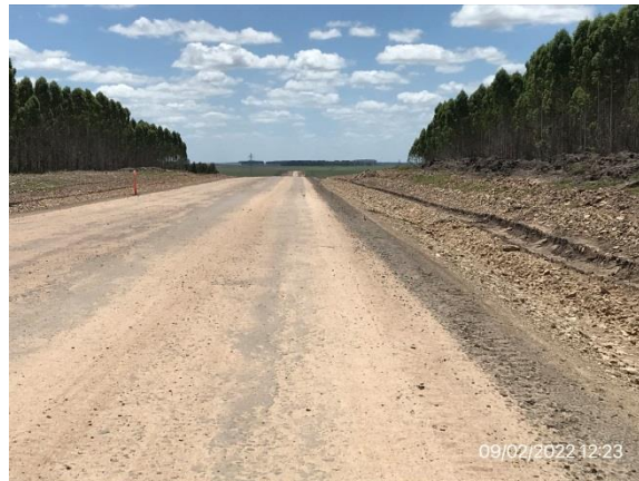
Ilustración 5 – Nuevo trazado de Ruta 20, base granular cementada terminada.
