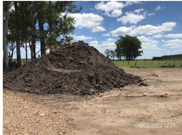
Ilustración 11 – P05, Campamento provisorio. Acopio de destape vegetal.
