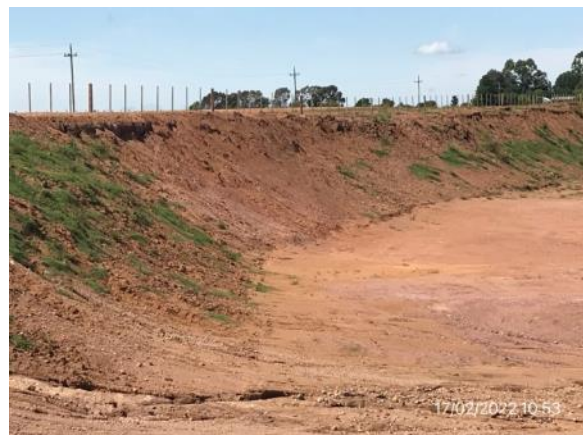
Ilustración 15 – P03, Cantera padrón N°9942 de Durazno. Tareas extractivas culminadas. Explanada de acceso y acopios remanentes a beneficio del propietario.
