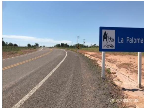
Ilustración 11 – P01, Inicio del tramo. Camino a la Balsa progresiva 31K950.
