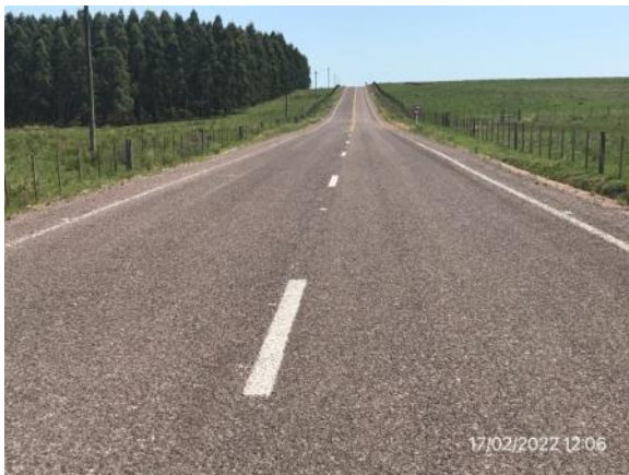
Ilustración 6 – Obras terminadas en Camino a la Balsa.
