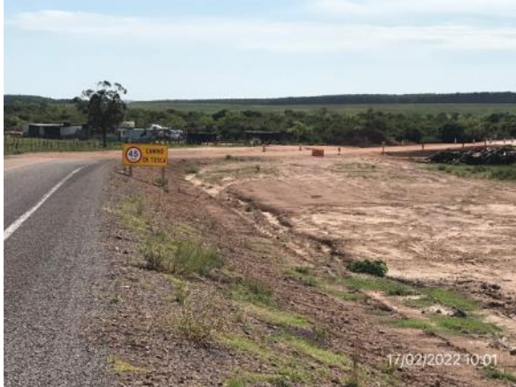
Ilustración 4 – P02, Fin del tramo. Acceso a Paso del Billar, A° del Cordobés.
