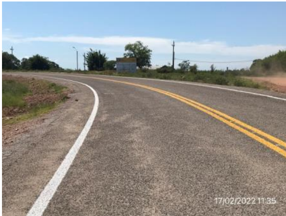
Ilustración 10 – P01, Inicio del tramo. Camino a la Balsa progresiva 31K950.
