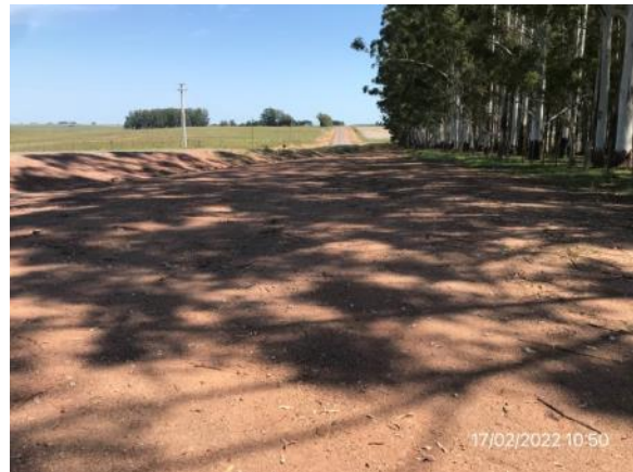
Ilustración 13 – P03, Obrador desmantelado. Explanada limpia de residuos e infraestructuras.
