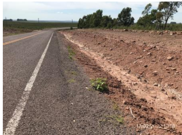
Ilustración 7 – Obras terminadas en Camino a la Balsa. Cunetas con empastado incipiente.
