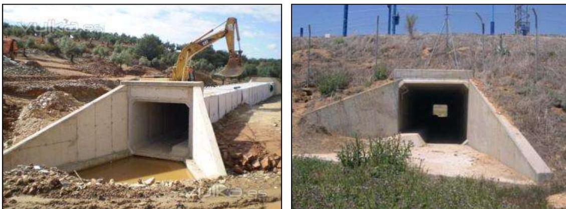
Figura 8-2 Ejemplos de vías de drenaje adaptadas para funcionar como pasajes de fauna.
