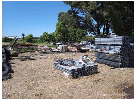
Ilustración 13 – P03, Obrador. Zona de acopio de material de obra.
