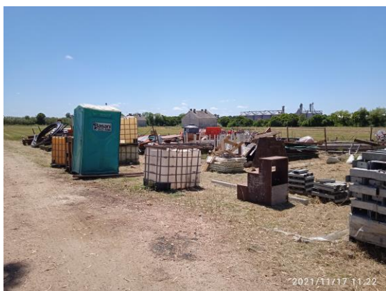
Ilustración 14 – P03, Obrador. Acopio de material para obra.
