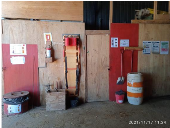
Ilustración 10 – P04, Obrador. Tarro para residuos peligrosos, kit antiderrame para frente de obra.
