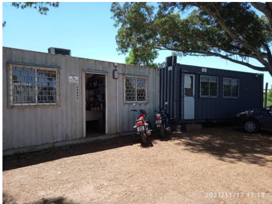
Ilustración 6 – P03, Obrador. Contenedores de oficinas.
