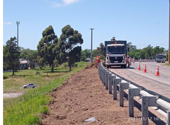
Ilustración 5 – Tareas de mantenimiento. Limpieza flex beam.
