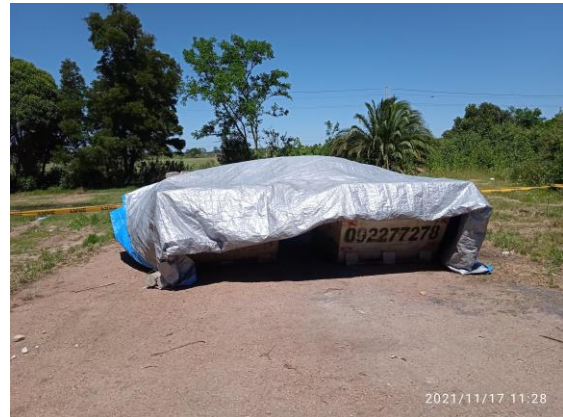
Ilustración 11 – P03, Obrador. Volquetas para acopio de residuos a enviar a SDF.
