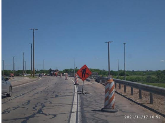
Ilustración 4 – Tareas de mantenimiento. Limpieza flex beam.
