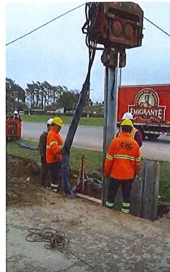
El procedimiento de hincado de TT comenzó con el túnel Este, desde norte a Sur, primero realizando Hincado de TT de calzada de servicio (1 y 2) y luego túnel central 3 y 4 en paralelo.
