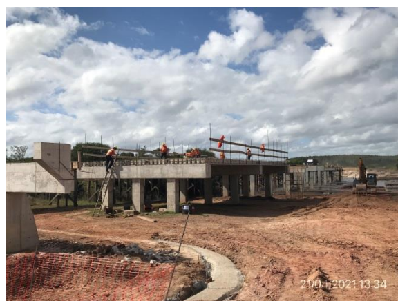
Ilustración 15 – P02, Puente en obra. Terraplenes de avance construidos.
