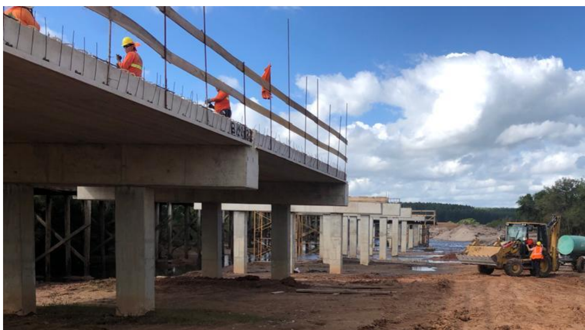
Frente de obra – Puente Paso del Billar – Empresa INCOCI S.A
