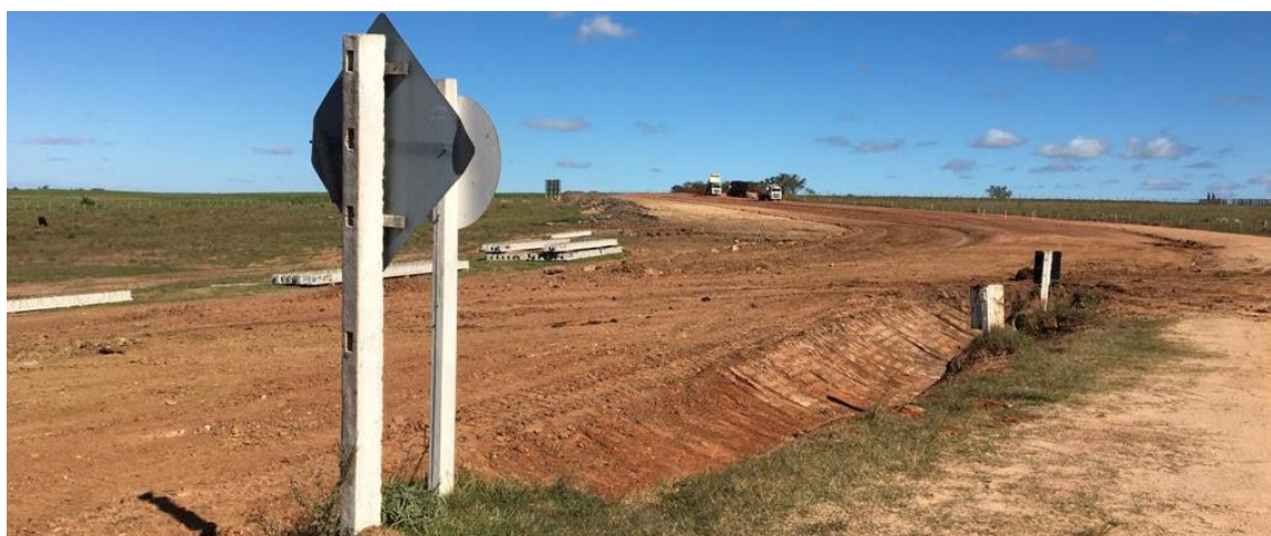
Frente de obra – trabajos en accesos – Empresa Meliter
