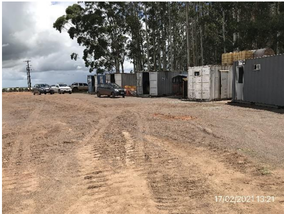
Ilustración 10 – P03 – Obrador. Vista general.
