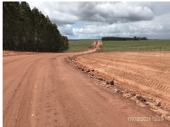
Ilustración 13 – Nueva traza del Camión de la balsa en obras, base compactada y cunetas conformadas.
