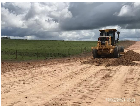
Ilustración 14 – P07 – Frente de obras en nueva traza del Camino a la Balsa.
