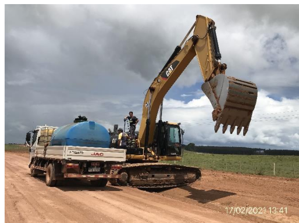
Ilustración 15 – P07 – Frente de obras en nueva traza del Camino a la Balsa.
