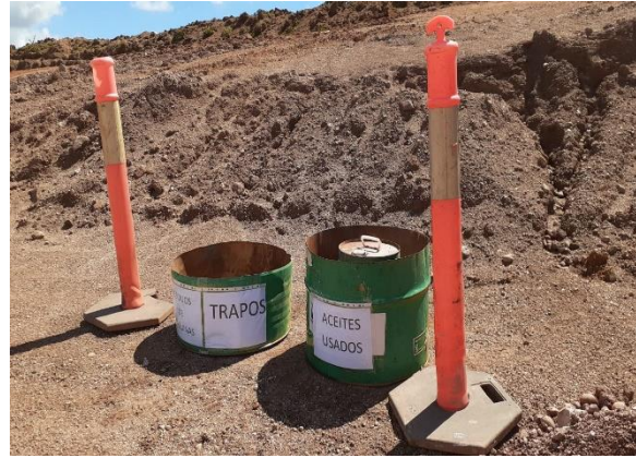
Ilustración 17 – P03 – Cantera. Nueva infraestructura para gestión segregada de residuos. Fotografía proporcionada por la empresa el 24/02/2021.
