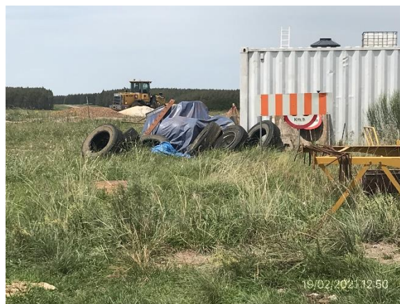
Ilustración 11 – P03, Obrador. Acopio de cubiertas usadas sin protección.
