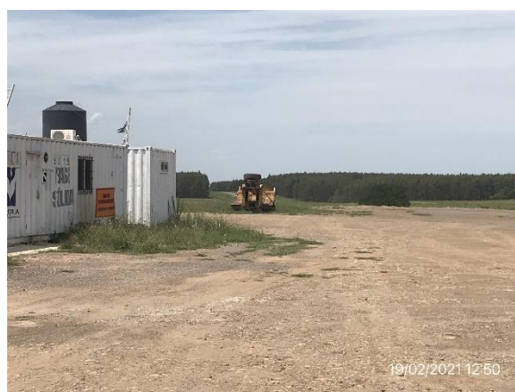
Ilustración 9 – P03, Obrador. Contenedores de oficinas y baños fuera de uso pero sin desmontar.
