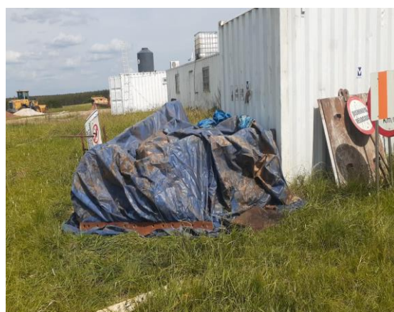
Ilustración 15 – P03, Obrador. Acopio de cubiertas usadas protegidas contra los agentes climáticos. Fotografía proporcionada por la empresa el 20/02/2021
