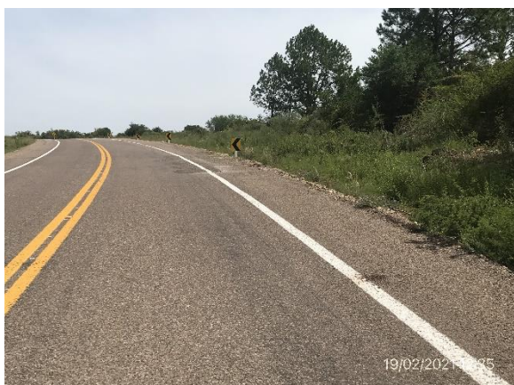
Ilustración 6 – Trabajos terminados en Ruta 4.
