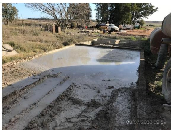
Ilustración 13 – P03, obrador. Planta de lavado de camiones mixer con zona de decantación y recirculación de agua
