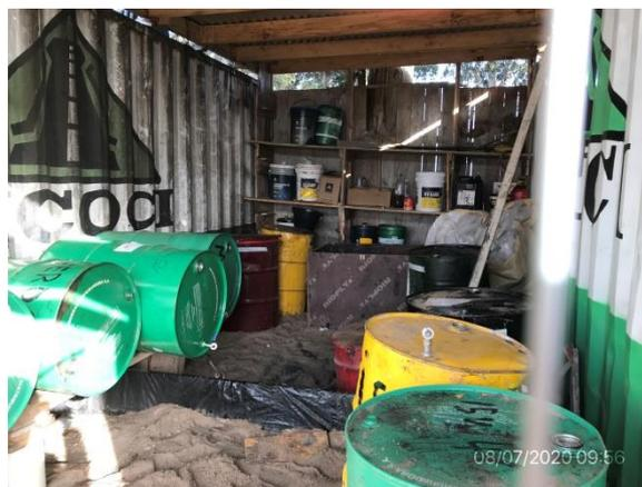
Ilustración 9 – P03, obrador. Sector techado y con pavimento impermeable para trasiego de lubricantes
