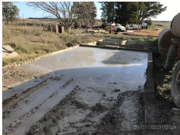
*Ilustración 17 – P06, obrador. Planta de lavado de camiones mixer con zona de decantación y recirculación de agua*
