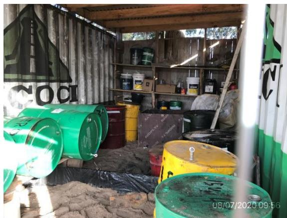
Ilustración 13 – P06, obrador. Sector techado y con pavimento impermeable para trasiego de lubricantes
