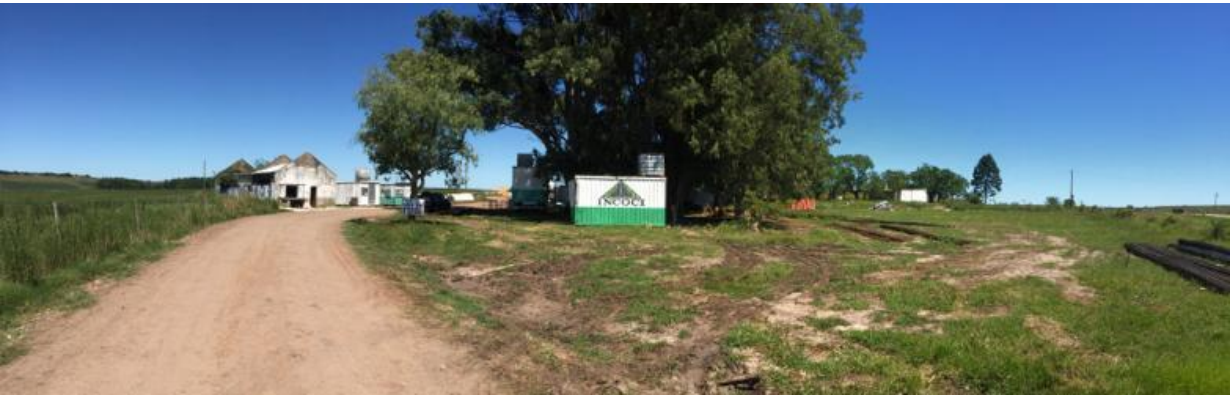
Fotografía de la entrada al obrador.
