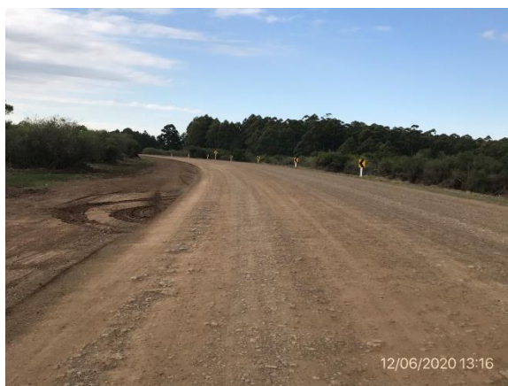
Ilustración 7 – Trabajos de perfilado de base en Ruta 4
