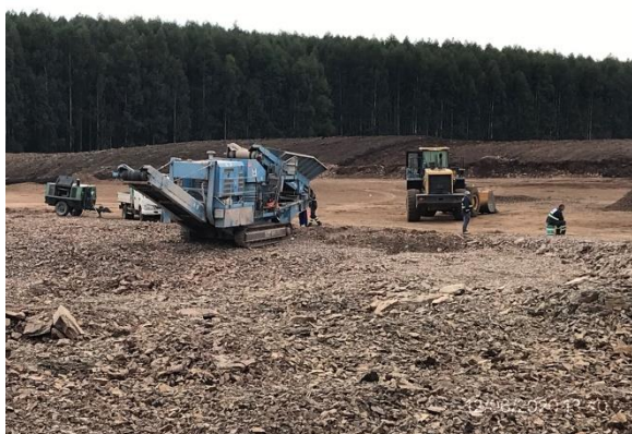
Ilustración 18 – P03. Cantera. Planta de trituración.
