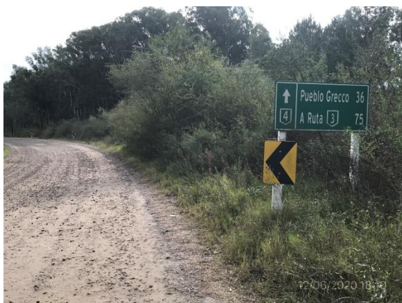
Ilustración 6 – Trabajos de reconformación de base en Ruta 4
