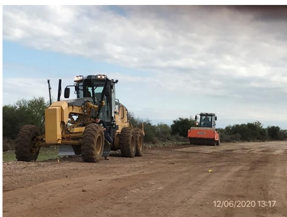
Ilustración 8 – Frente de obras en Ruta 4.
