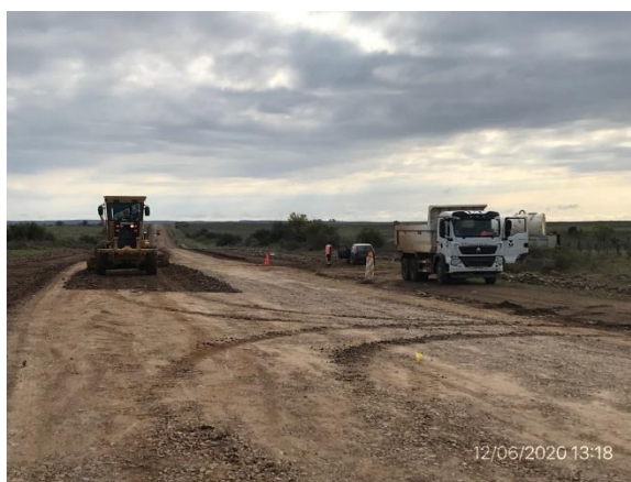
Ilustración 9 – Frente de obras en Ruta 4.
