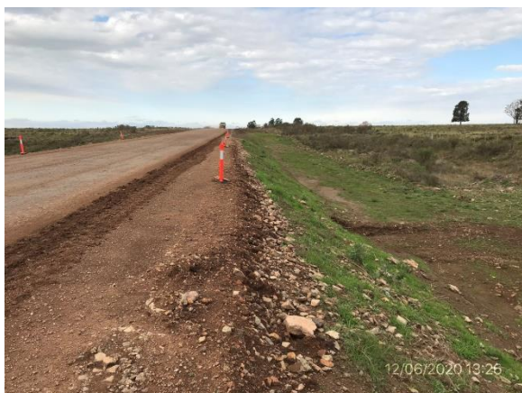
Ilustración 10 – Trabajos de perfilado de faja pública de Ruta 4
