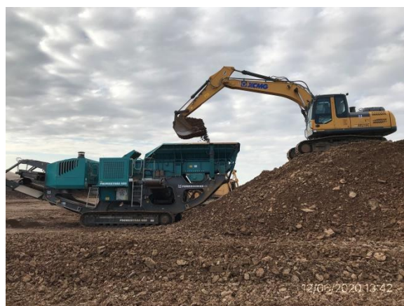
Ilustración 19 – P03. Cantera. Acopios de áridos
