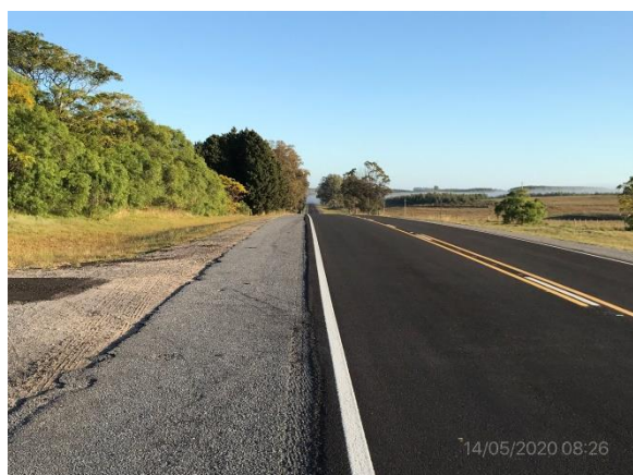
Ilustración 6 – Tramo de obra en Ruta 3 256K000 a 308K900, tareas de fresado y recapado terminadas
