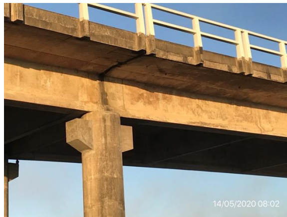
Ilustración 5 – P01, frente de obras en puente de Ruta 3 sobre A° Grande, sustitución de neoprenos
