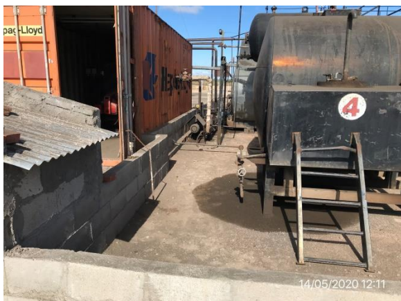
Ilustración 12 – P06. Obrador central de Gofinal S.A, planta asfáltica con vallado perimetral
