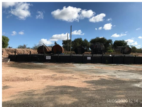
Ilustración 13 – P06. Obrador central de Gofinal S.A, tanques de emulsión asfáltica con vallado perimetral
