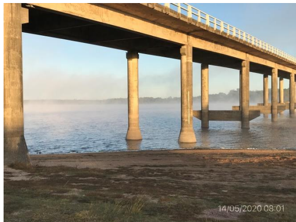
Ilustración 4 – P01, frente de obras en puente de Ruta 3 sobre A° Grande, sustitución de neoprenos
