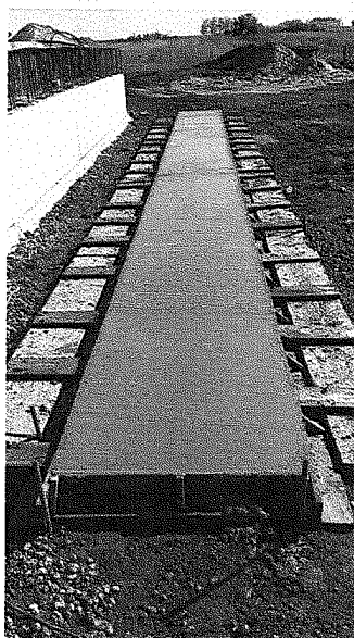
Imagen 14 y 15 – Piso y llenado de vigas prefabricadas
