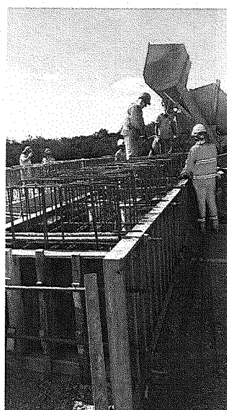
Imagen 14 y 15 – Piso y llenado de vigas prefabricadas
