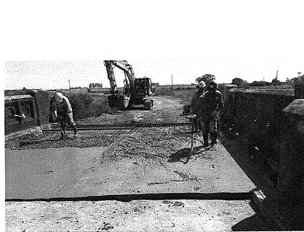
Imagen 2, 3, 4 y 5 – Reparación de losas de acceso del puente viejo
