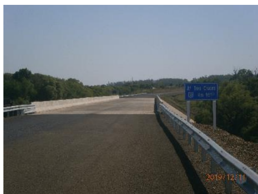
Ilustración 15 – Frente de obra, Puente sobre A° 3 Cruces
