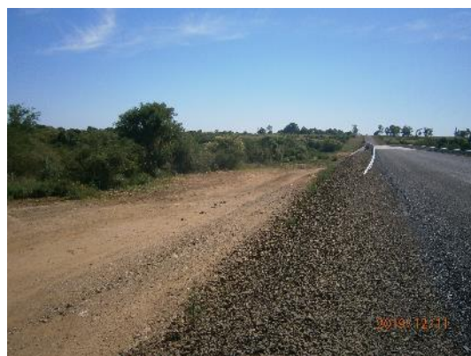
Ilustración 17 – Fronte de obra, Puente sobre Cda La Bomba
