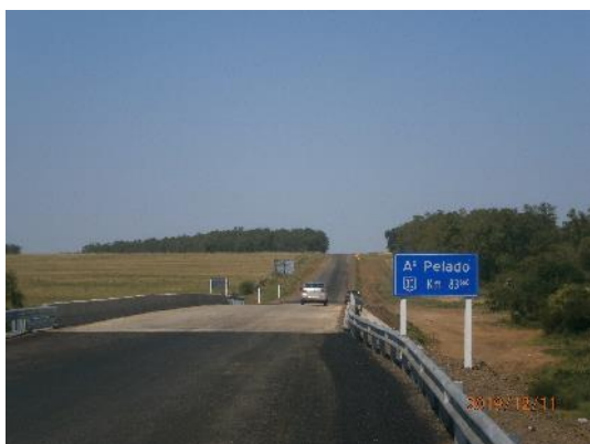
Ilustración 16 – Fronte de obra, Puente sobre el arroyo Pelado
